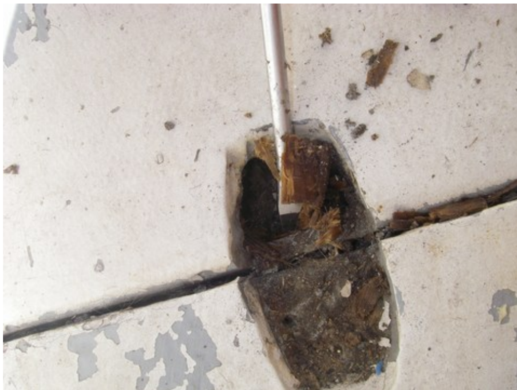
Dégommage du balsa
