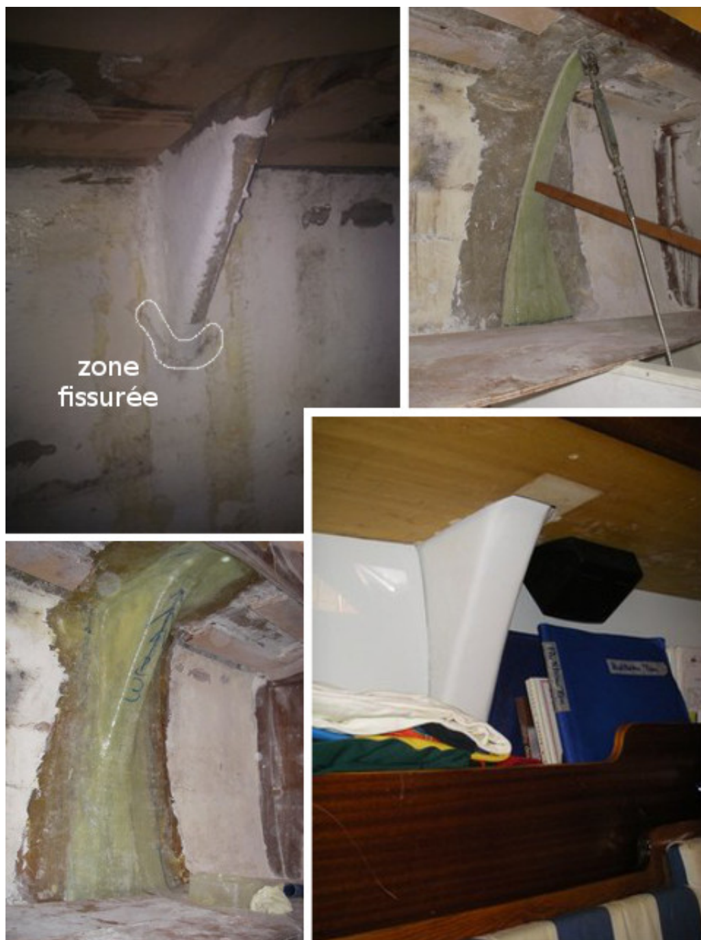
des travaux côté bâbord
