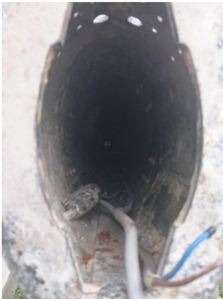
L'intérieur du mât après : pas de superflu
