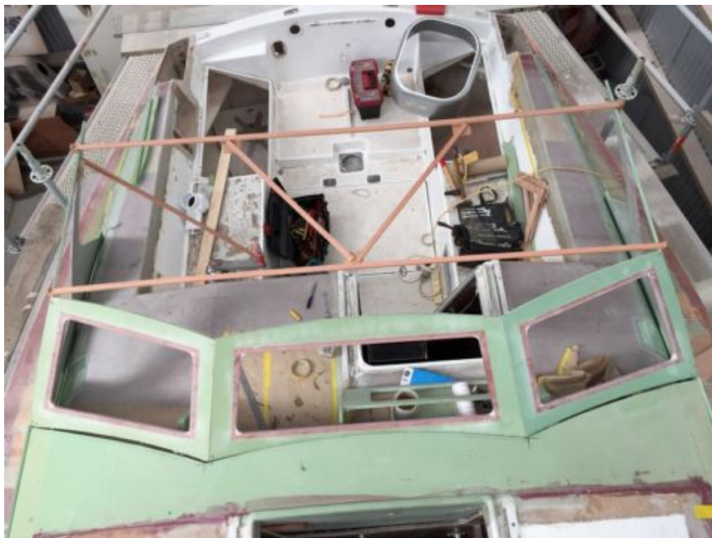
vue du pont
